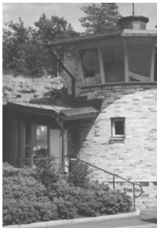
Biomassza tüzelésű erőmű
